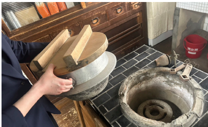
釜の下に配置された五徳(ごとく)。床下からのガス管と接続されている。
