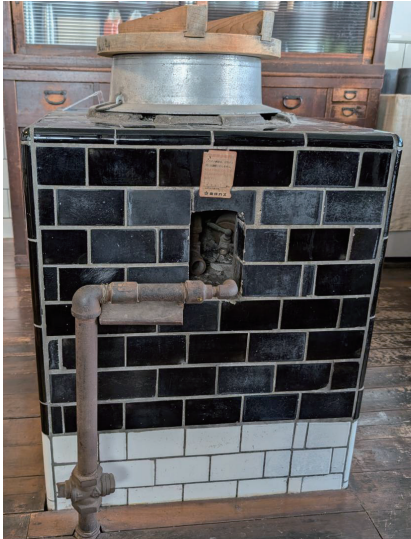
床下より釜戸側へ設置されていたガス管(写真2)
