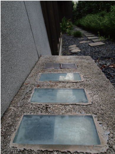
写真⑤ガラスブロックが埋め込まれた石材/非公開
