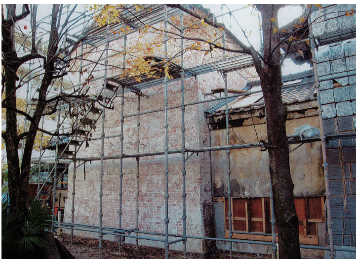
写真①: 蔵の修理工事(2008年裏庭から撮影)東蔵(左)は煉瓦、西蔵(右)は瓦。
