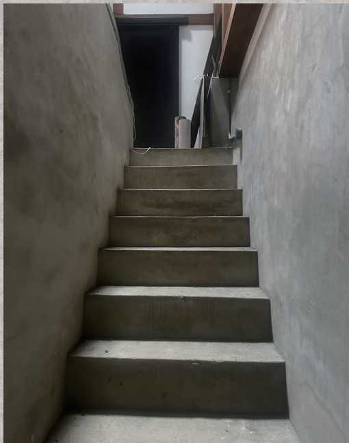
西藏の地下室への階段
