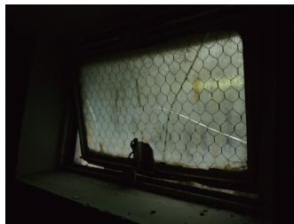
写真④地下室の押し開窓
